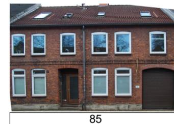
Bei Sanierung der Fenster wurde keine senkrechte Teilung gewählt. Haustür und Fenster haben unterschiedliche Farben. Die Ziegelfassade ist erhalten und wurde für den Einbau eines Garagentores, das in seiner Ausführung die historisch geprägte Ansicht stört, ausgebessert.
