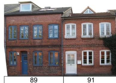
Bei Sanierung der Fenster wurden Holzfenster mit Sprossen gewählt, was sich positiv auf die traditionelle Fassadengestalt auswirkt. Haustür und Fenster haben die gleiche Farbe. Die Ziegelfassade ist gut erhalten und wurde bei Nr.89 für die Erhöhung des Drepfels harmonisch ergänzt.
