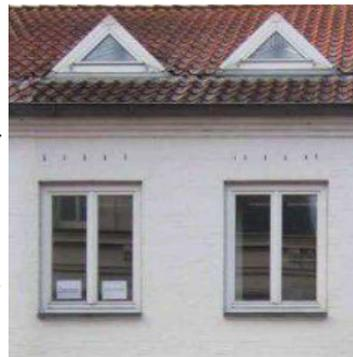
Vormauerung aus Handstrichziegeln Holzfenster mit Sprossenteilung Haustür aus Holz mit Sprossenteilung Traufgesims mit Holzverschalung unpassend, positiv: Grenadierschicht als Traufabschluss
